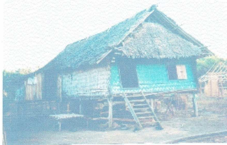
FOTO 02. Salah satu rumah Penduduk di desa Jotang, Kec. Empang Atas. Kecuali kolom, balok dan tangga, lainnya masih menggunakan bahan bambu.
