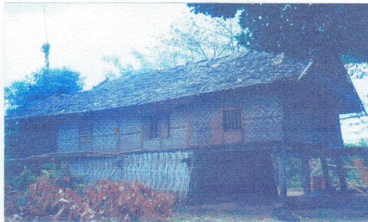
FOTO 01. Rumah Tradisional Samawa yang masih menggunakan bahan bambu Kecuali kolom dan balok utama. Di desa Batu Lante, Kec Moyo Hilir.
