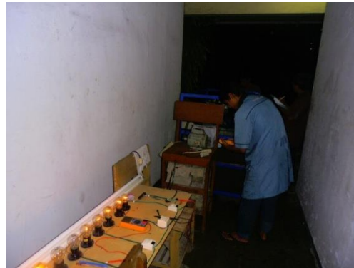
Gambar 10. Generator MISG & Beban Lampu
