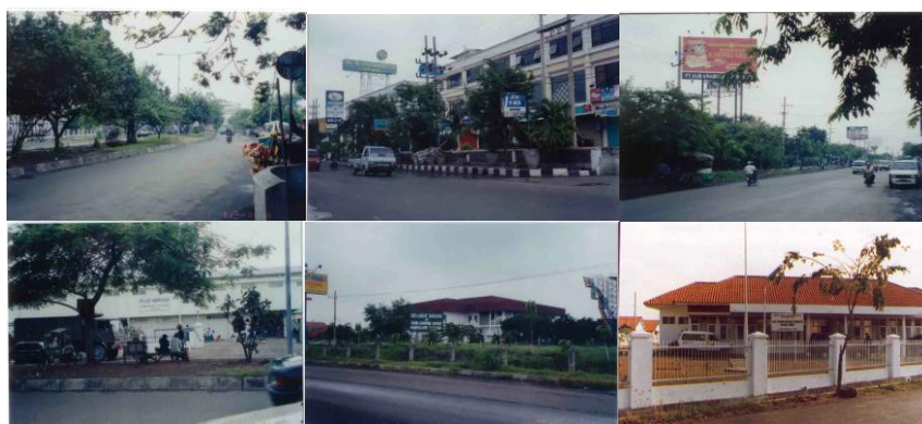
GB.5.2. KONDISI SARANA DAN PRASARANA PADA KAWASAN RUNGKUT SURABAYA
